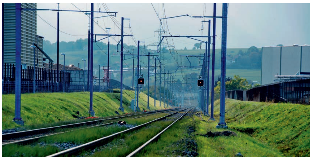
Voies ferroviaires à la ZIMEYSA
